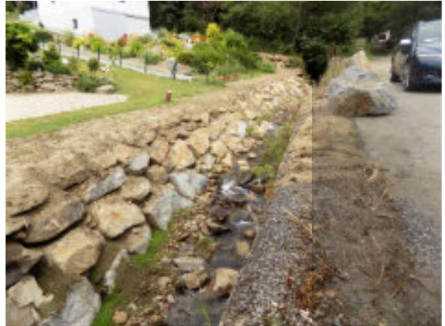
**Bachbettsanierung Steinbach** | Im Steinbach, im unteren Bereich des alten Riegler-Areales, kam es zu einer Uferausschwemmung. Da in diesem Bereich auch Kanal und Wasser direkt neben dem Steinbach geführt werden, bestand die Gefahr, dass diese ausgeschwemmt und freigelegt werden könnten. Aus diesem Grund wurde durch einen Betreuungsdienst der Wildbach- und Lawinenverbauung eine Ufersicherung mittels Wurfsteinen durchgeführt.
